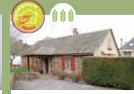
LE TONDUT Le Tondut 12490 Viala-du-Tarn +33(0)5 65 62 88 31
